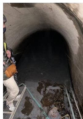
民家の庭に残る坑口
